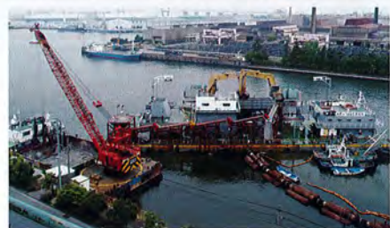
管中混合工法
