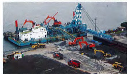
落下混合工法
